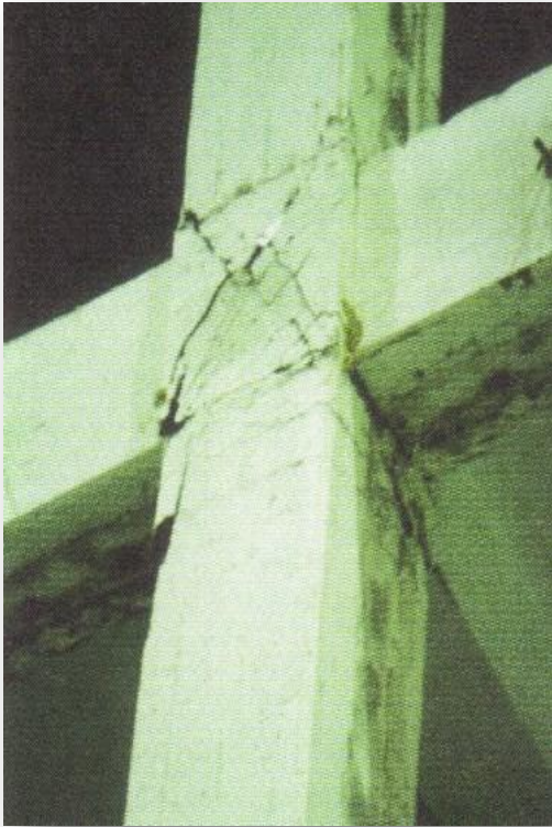
Εικόνα 4: Χιαστί κολλάρα [4]
