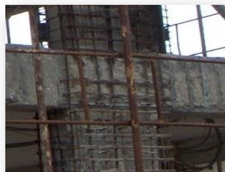
Εικόνα 3: Μανδύας οπλισμένου σκυροδέματος [9]
